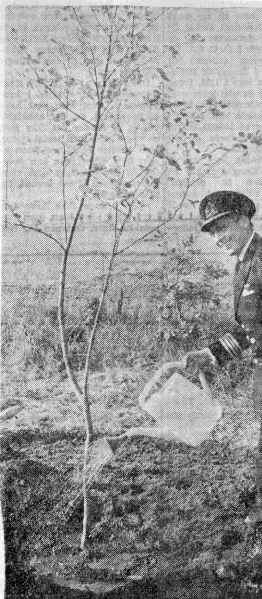
— Og vandes skal det jo også. Det grove forarbejde udført af et hold erfarne civilarbejdere.
